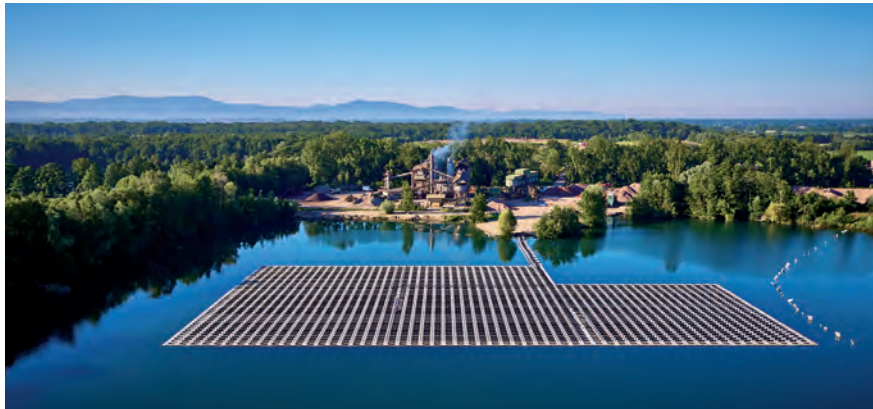
Schwimmende PV-Anlage der Erdgas Südwest in Renchen (©Ossola GmbH)
