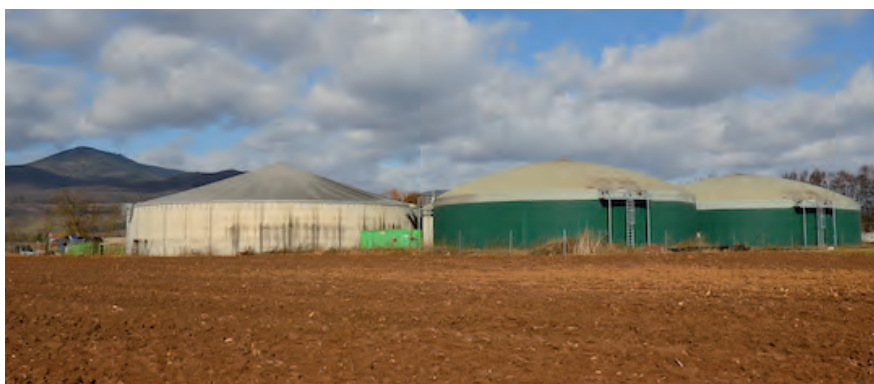
Faultürme von Agrivalor in Ribeauvillé (©Frederic Douard, Bioénergies International)
