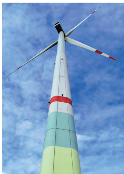
Windpark der Energie Südwest GmbH in Offenbach (©TRION-climate e.V.)
