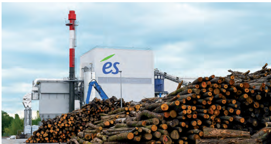
Installation biomasse d'Électricité de Strasbourg au Port autonome (©Electricité de Strasbourg)
