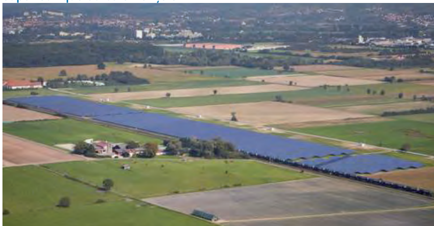
Installation photovoltaïque à Hohberg (©ADSOBA GmbH)
