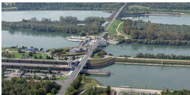
Centrale hydroélectrique à Iffezheim de l'Energie Baden-Württemberg EnBW (©EnBW)
