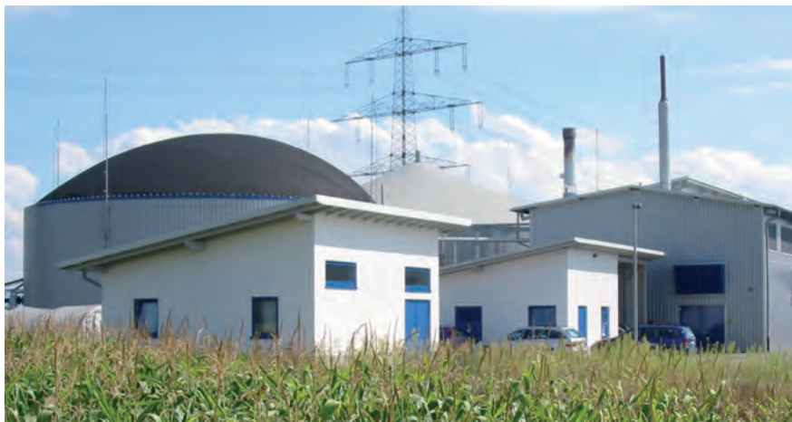
Centrale biogaz de la Badenova à Neuried (©Badenova AG&Co.KG)
