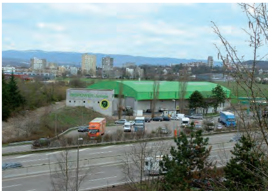
Centrale biogaz de Biopower Nordwestschweiz (©EBL-Elektra Birseck Münchenstein)
