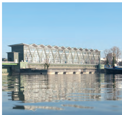
Centrale hydroélectrique de Birsfelden à Basel (© Christian Flierl / IWB)
