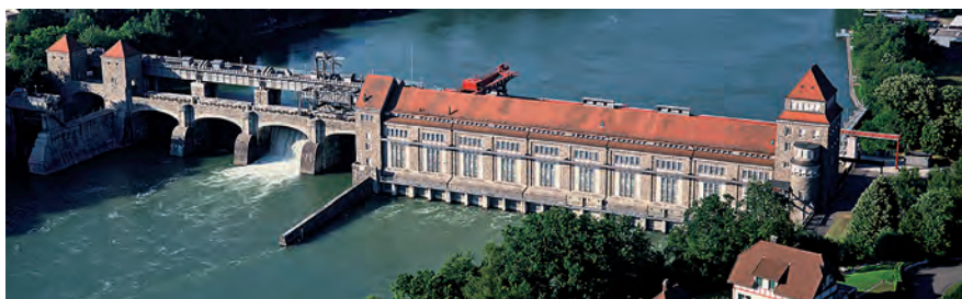
Centrale hydroélectrique à Laufenburg de l'Energiedienst Holding AG (©Energiedienst Holding AG)
